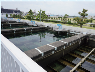
大治浄水場のろ過設備
